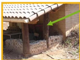
Ces poteaux soutenant la toiture sont aussi en pin d'Alep, prélevés sur le terrain.
