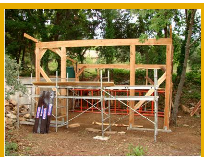
Ossature en bois de pin d'Alep
