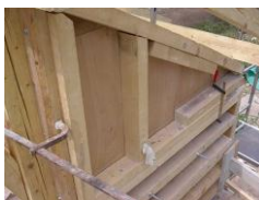
+ serre joint de maçon + demi-madrier fixé sur contreplaqué
