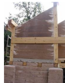
Mur en pisé après décoffrage
