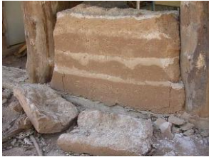
1 er test pisé: le mur s'est craqué de toute part.
