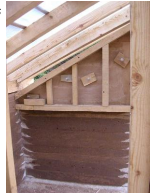
Mur du 2 ème test après décoffrage
