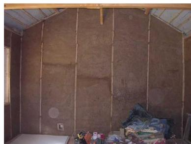
Mur de la salle polyvalente recouvert d'enduit en terre-naille
