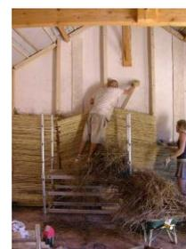
Bourrage de la paille de lavande entre le mur et les canisses
