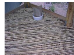
Installation des cannes de Provence
