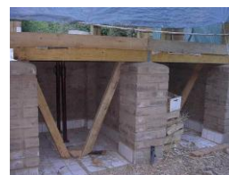
Coffrage du plancher
