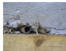
Dalle béton ciment-paille cannes de Provence
