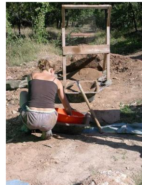
Tamisage de la terre qui servira pour le mortier terre
