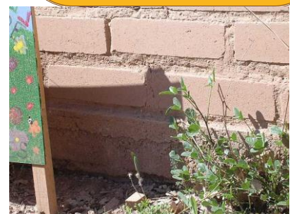
Protection du mur en BTC par une semelle en béton armé (contre les remontées d'eau) au dessus des fondations.
